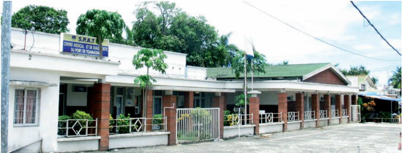
Vue de la façade du CEMEDI, le centre médical de la SPAT
