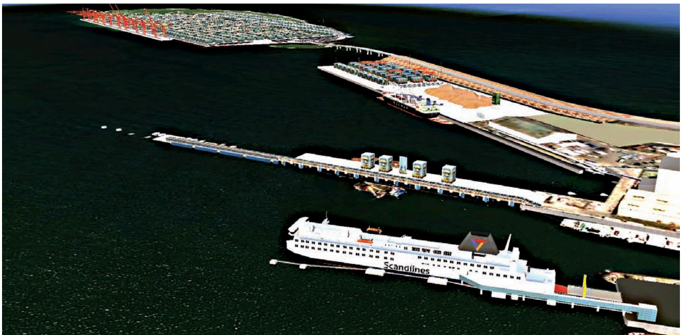
La construction d'un quai passagers figure dans la plan d'extension du port de Toamasina
