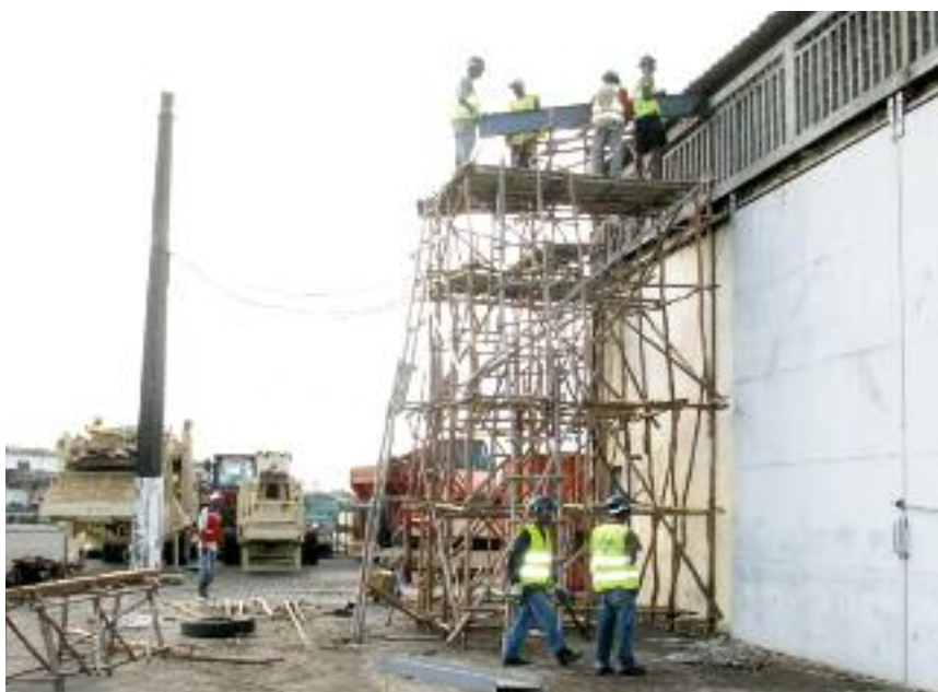
Techniciens de la SMMC, à pied d'oeuvre pour la réhabilitation d'un magasin
