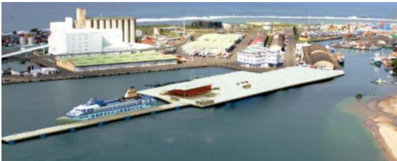
Vue du quai mixte passagers/Ro-Ro, projet 2014-2015
