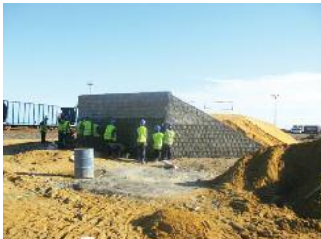
Travaux de remblaiement pour recevoir un nouveau faisceau de voie ferrée raccordé au site de stockage de chromite
