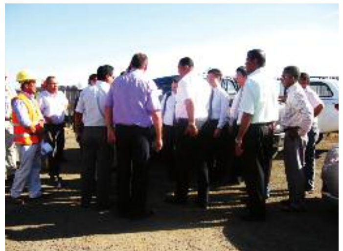
Constat de l'état d'avancement des travaux
