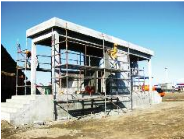
Fondation du nouveau kiosque du poste de contrôle d'entrée et de sortie des marchandises au niveau du portail n°5
