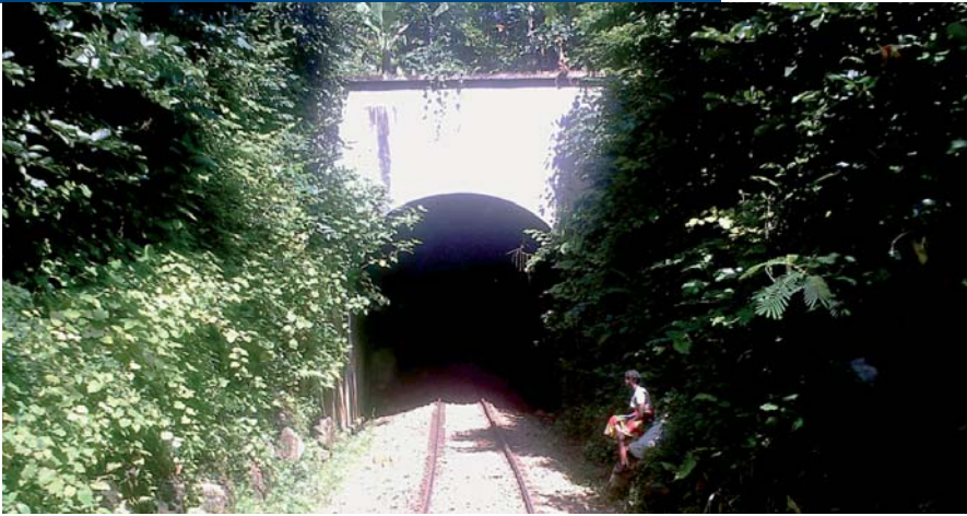
Tunnel Gallieni, l'un des célèbres tunnels le long de la ligne TCE
