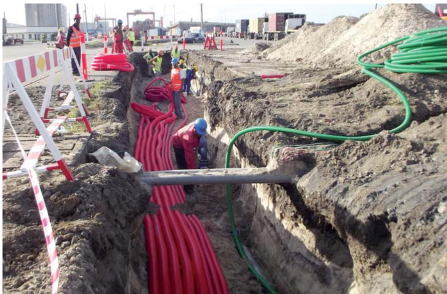
Aménagement du réseau d'eau et de l'éclairage public
