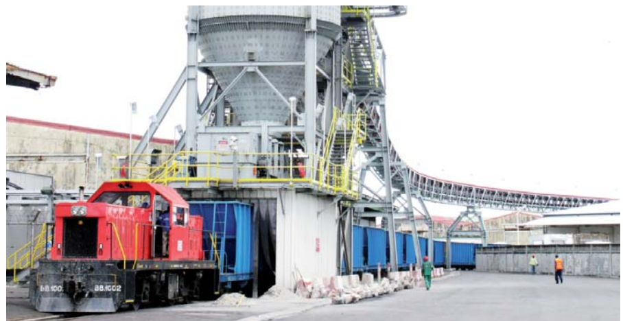
Trémie de déchargement des intrants d'Ambatovy sur des wagonnets
