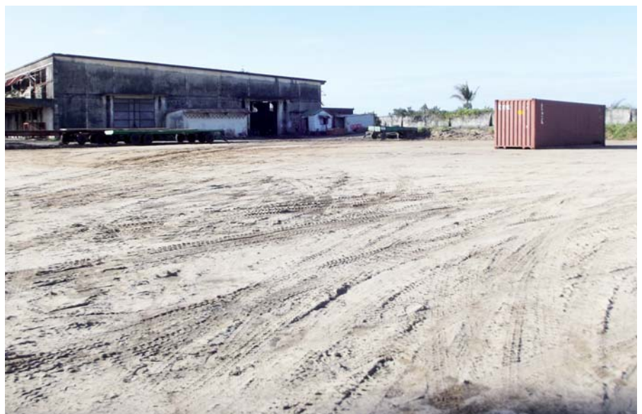
Aménagement de nouvelles aires de stockage de conteneurs du côté sud de l'hangar 16 jusqu'à la limite de la zone Raymond BANG
