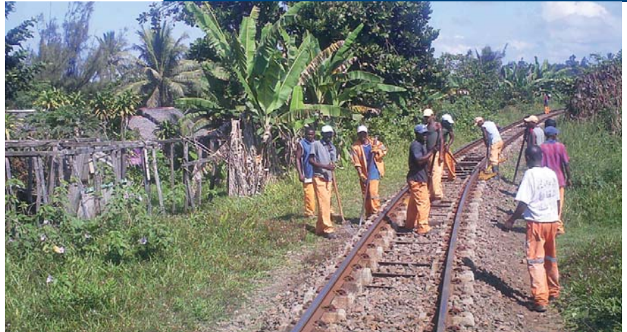
L'entretien du rail par des ouvriers
