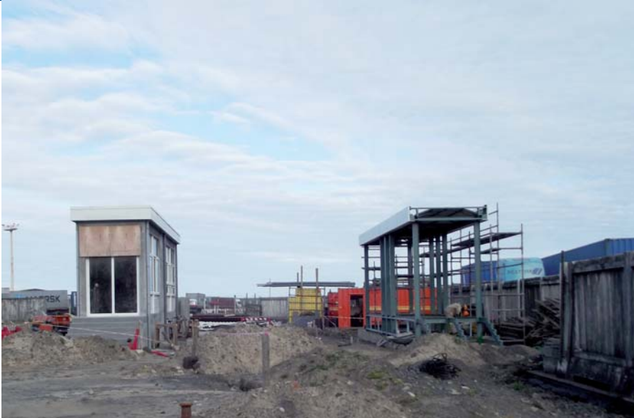
Aménagement du poste de contrôle d'entrée et de sortie des marchandises au niveau du portail n°5
