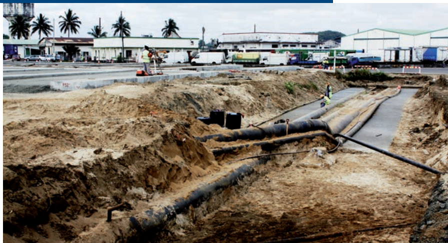
Lot n° 03: Tranchée en vue de l'adduction d'eau et d'électricité
