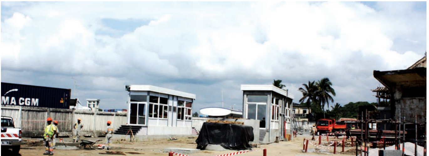
Le portail n°5 en plein chantier
