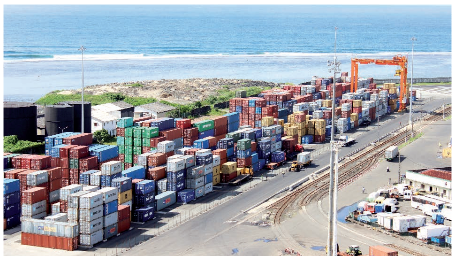
Aménagement de terre plein pour conteneurs, un investissement en génie civil
