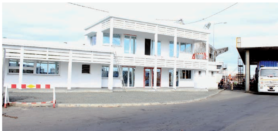
L'un des deux bâtiments administratifs au niveau du Portail n°5
