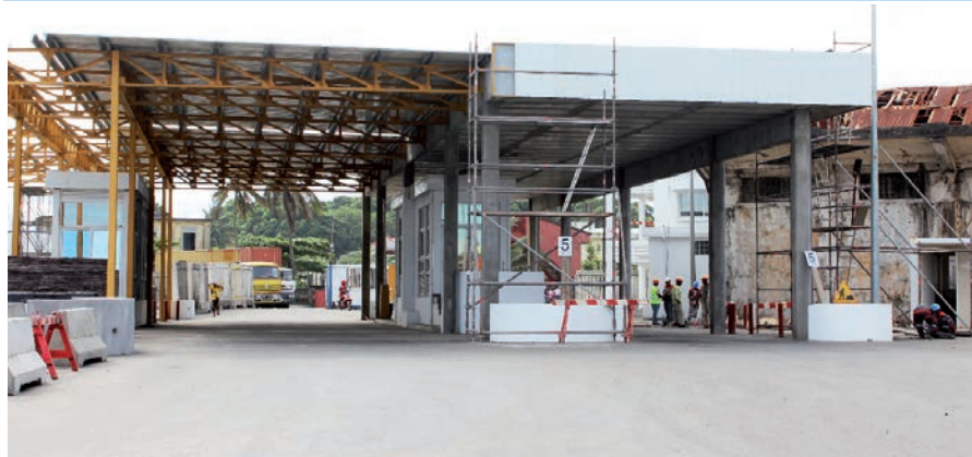
Etat d'avancement du chantier relatif au préau
