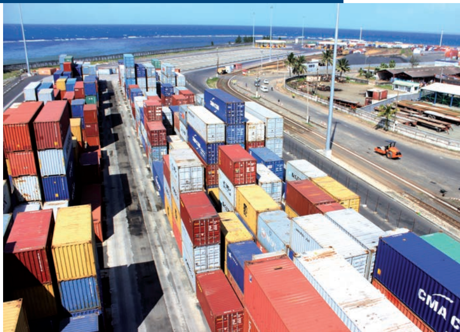
Vue partielle du nouveau terminal à conteneurs
