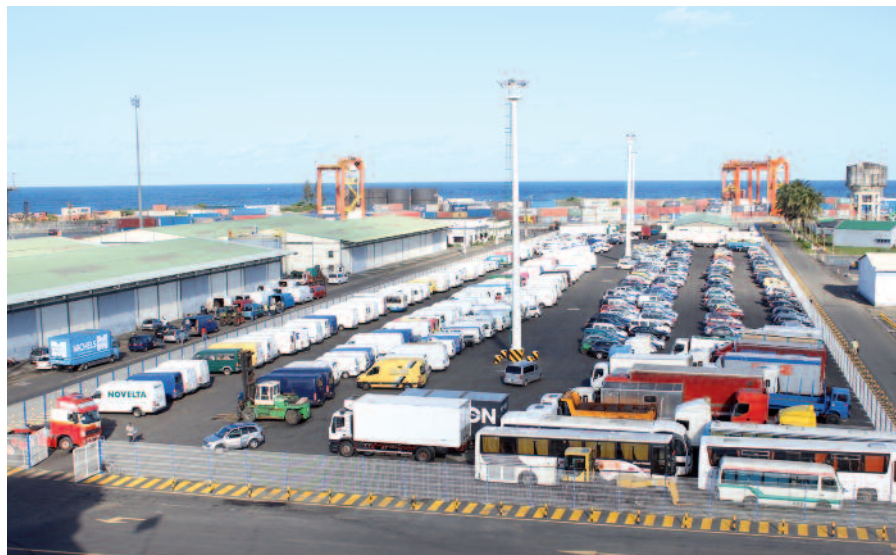
Parmi les travaux récemment réalisés, un nouveau parc à voitures à la disposition de la SMMC
