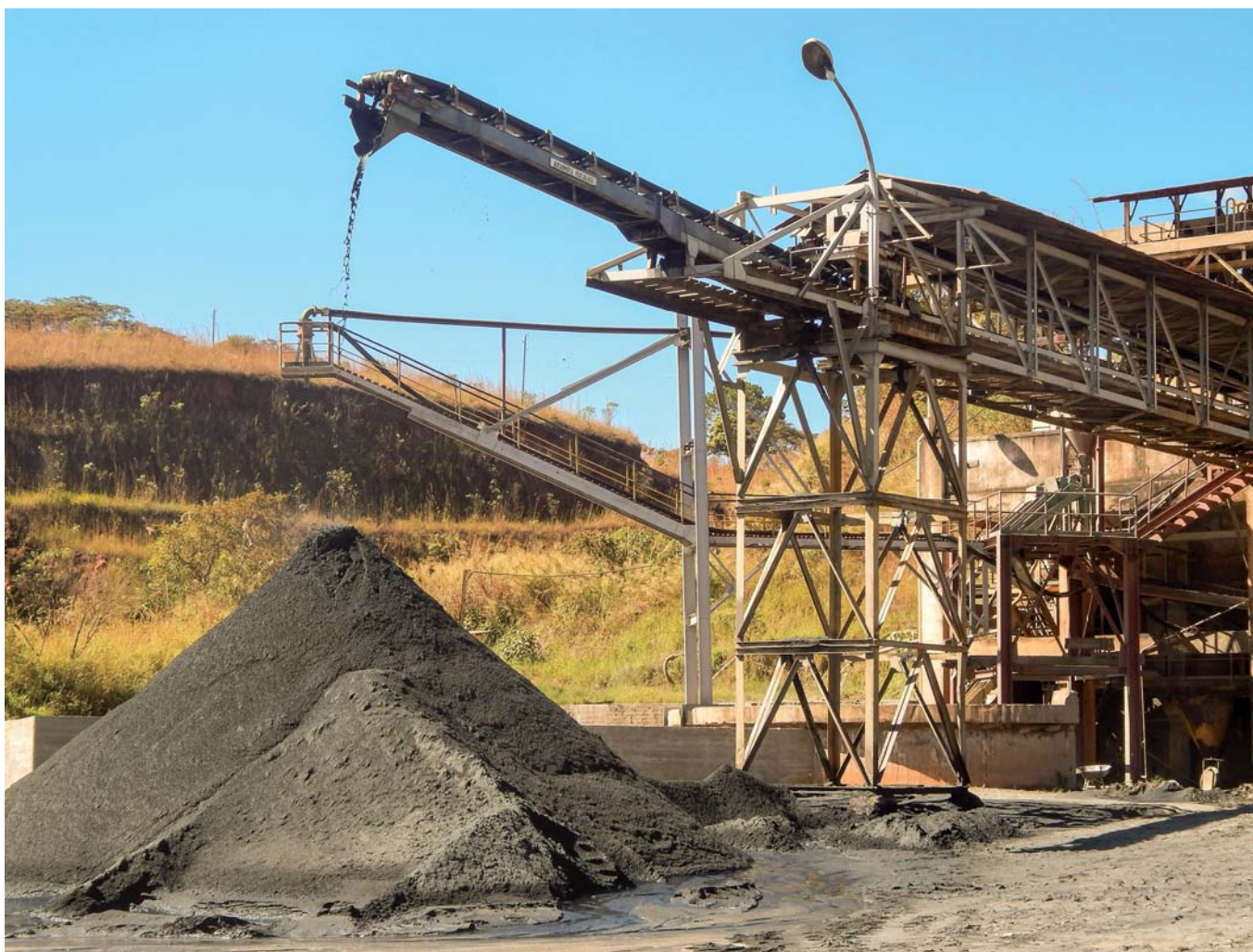
Vue partielle de l'unité d'exploitation de la chromite
