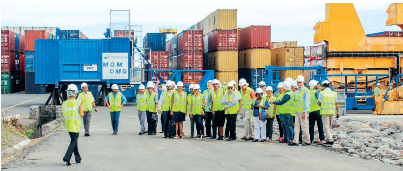
Visite de site guidée aux chantiers du port (La Réunion)
