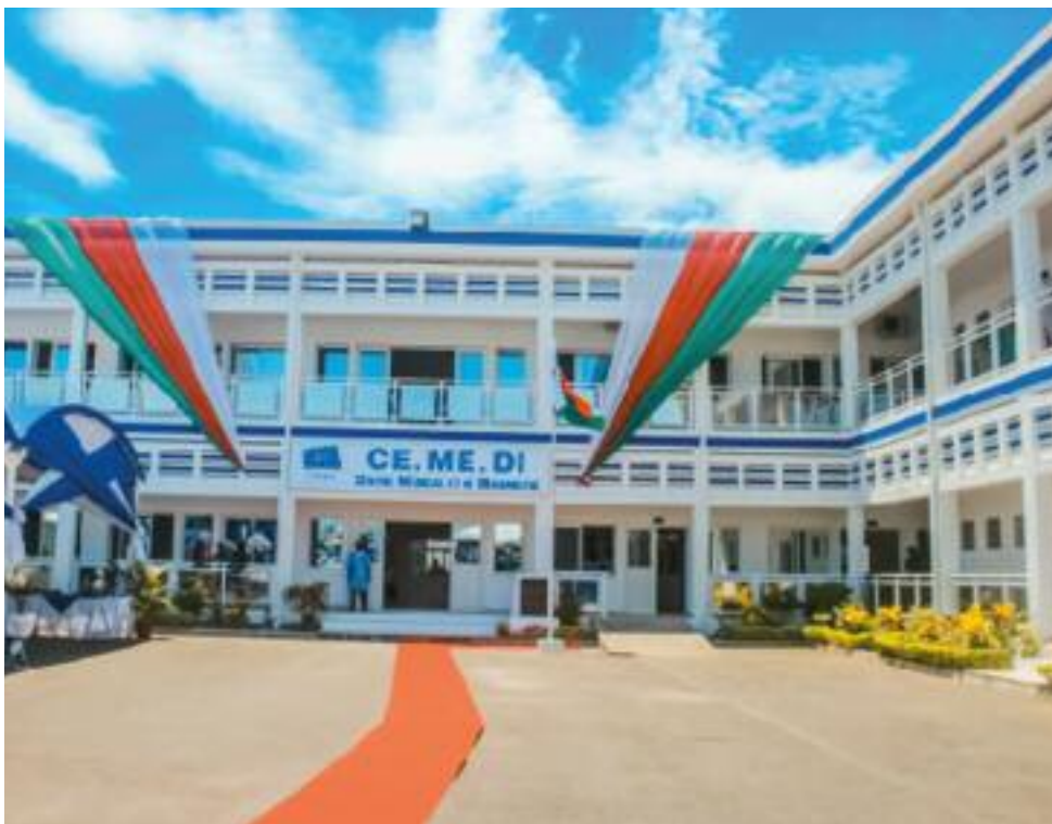
CEMEDI-SPAT, parmi les nouvelles infrastructures inaugurées dans l'enceinte du port de Toamasina
