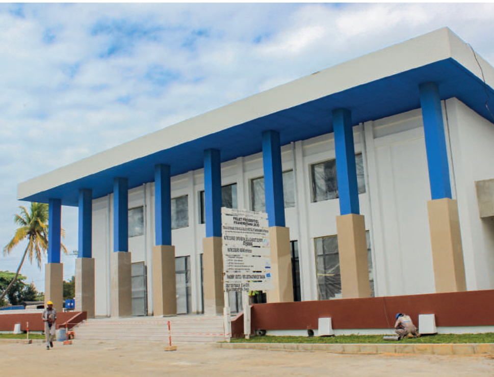
Salle de spectacle du CRJS, en pleine rénovation
