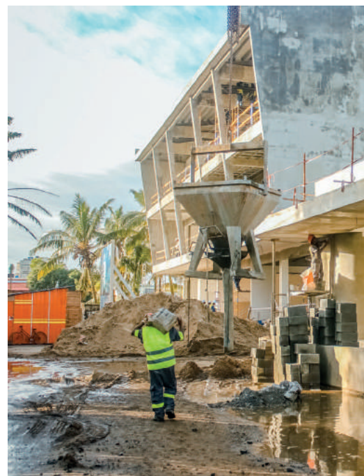
Chantier du Port Academy Center
