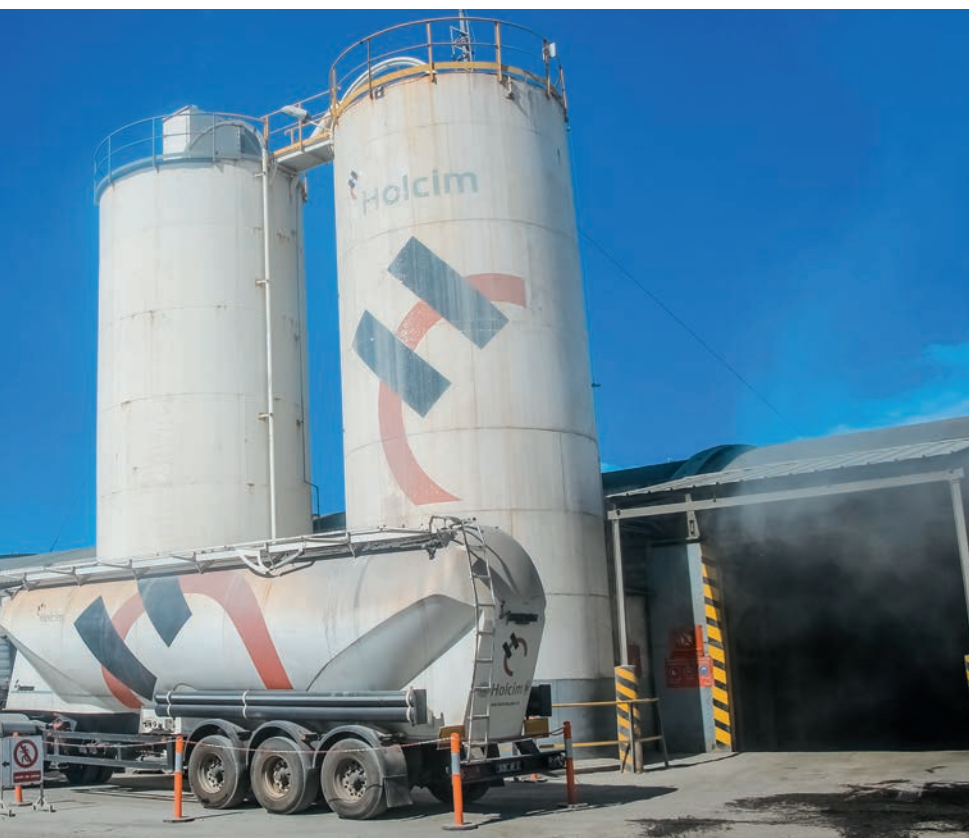
Silo de stockage de ciment en vrac sis dans l'enceinte du Port de Toamasina
